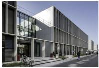
Côté nord, la résille de béton d'une épaisseur de 40 cm s'adapte à l'orientation et
