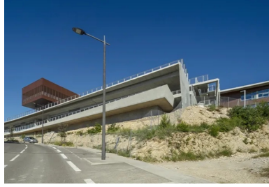
Avec son dernier niveau traité en porte-à-faux, le bâtiment crée un signal fort dans le paysage et affiche son caractère d'équipement emblématique.
