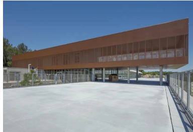
Dans la cour principale, l'étage supérieur en porte-à-faux dessine un préau naturel.
