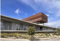
Le dernier niveau en porte-àfaux repose sur d'épaisses équerres de béton successives qui confèrent une dimension tectonique à l'ensemble.
