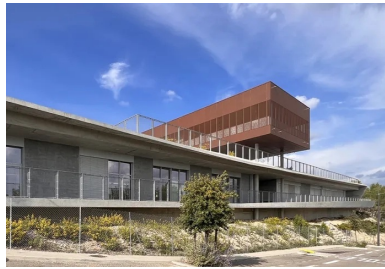
Le dernier niveau en porte-à-faux repose sur d'épaisses étrées de béton successives qui confèrent une dimension tectonique à l'ensemble.
