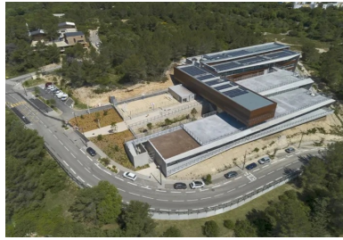
Le bâtiment s'implante dans la topographie et s'organise comme si trois rez-de-chaussée avaient été empilés pour profiter à chaque niveau d'un prolongement extérieur.
