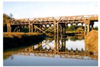
truit en 1916, le pont du Marais peut être considéré comme un prototype en tant que premier pont en béton au monde entièrement préfabriqué et assemble place. Il a bénéficié d'ur
