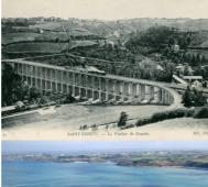
Construit à Saint-Brieuc en 1904, le viaduc de Souzain était un ouvrage complexe en trois parties : un ouvrage d'accès, un ouvrage m'accès, un ouvrage principal et une dérivation. D'une longueur totale de 274 m pour une hauteur de 35 m et une largeur de 11,40 m, il a été détruit le 27 juin 1995. (© DR)
