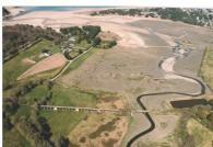
Ancien pont de la voie ferrée Yffiniac-Matignon, situé à Plurien, la passerelle de la Côtière a été construite en 1916. Elle comporte 27 traversées en béton armé reposant sur des piles en maçonnerie espacées de 5,60 m, supportant un hourdis en béton armé coulé sur place. Sa longueur est de 164 m pour une largeur de 3,90 m et une hauteur maximale de 7,40 m. C'est la plus importante des passerelles subsistantes dans le département des Côtes-d'Armor.
