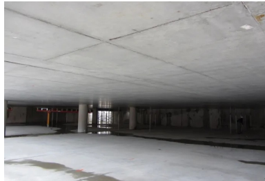
Parking Gérard Philippe - La Garde (Var). La technique des planchers précontraints par post-tension est particulièrement bien adaptée à la configuration des parkings. Les dalles plates permettent de dégager de vastes trames sans poteau (ici 15 m x 8 m), ce qui optimise la répartition des places de stationnement et la circulation des voitures. Par ailleurs, l'absence de poutre dessine des surfaces régulières facilitant le passage des réseaux et simplifiant la cinétique de ventilation. © FREYSSINET
