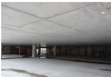
Parking Gérard Philippe - La Garde (Var). La technique des planchers précontraints par post-tension est particulièrement bien adaptée à la configuration des parkings. Les dalles plates permettent de dégager de vastes trames sans poteau (ici 15 m x 8 m), ce qui optimise la répartition des places de stationnement et la circulation des voitures. Par ailleurs, l'absence de poutre dessine des surfaces régulières facilitant le passage des réseaux et simplifiant la cinétique de ventilation. © FREYSSINET
