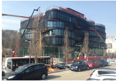
Le Pavillon 52 - situé dans le quartier Lyon Confluences (Rhône). Cet immeuble de bureaux en R+6, conçu par l'architecte Rudy Ricciotti, développe une surface de 7 700 m 2 . La technique des planchers précontraints par post-tension a été choisie par le maître d'œuvre pour au moins trois raisons : la nécessité de disposer de grands plateaux, la capacité à épouser les formes ondulantes des différents niveaux, et la possibilité d'y intégrer un système de plafond chauffant. © FREYSSINET
