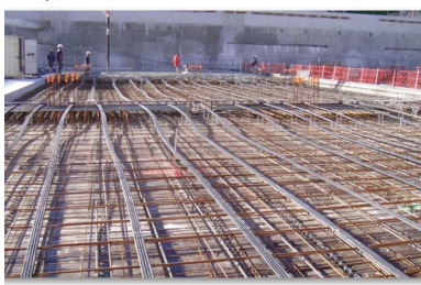
Parking Gérard Philippe - La Garde (Var). Installation des câbles de précontrainte avant coulage, longitudinalement et transversalement. La compression générée par la précontrainte permet de diminuer la quantité d'armatures passives. © FREYSSINET
