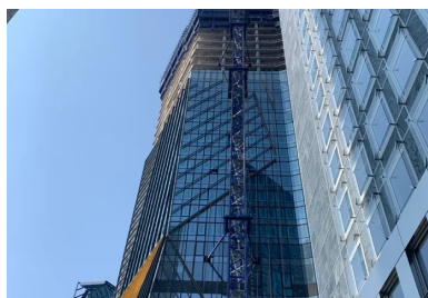
Tour Hekla - La Défense (Hauts-de-Seine, architecte Jean Nouvel). Les 46 niveaux de cette tour de 220 mètres de haut sont constitués de planchers précontraints par post-tension. Cette solution technique permettait de s'adapter à la forme unique et complexe de la tour - tous les planchers disposent d'une géométrie unique - tout en respectant les délais de construction et en diminuant l'empreinte carbone de l'ouvrage de 30 % par la réduction des quantités de béton et d'armatures d'acier. © FREYSSINET
