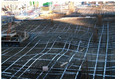
Hôpital Mater - Dublin (Irlande). Les câbles de précontrainte sont installés en suivant une forme de « vague ». Cette ligne suit la courbe des moments des forces qui s'exercent dans le plancher. © FREYSSINET
