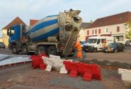
Le béton drainant est déversé entre coffrages sur la plate-forme support
