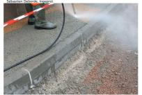
Dans un délai de 24 heures après le coulage, le béton est lavé au surpresseur (©Grégory Charpenet, Béton Vicat).
