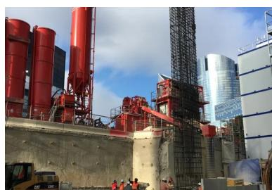
Leverage de la cage d'armature d'une paroi moulée avant son installation dans la tranchée. Cette phase spectaculaire permet de se rendre compte des dimensions exceptionnelles de l'excavation.
