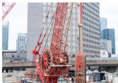
Vue d'une benne preuseuse hydraulique. Cette machine était utilisée pour l'excavation des sols meubles. Pour les sols plus durs, elle était remplacée par une hydrofrase, une hacheuse de paroi mise au point par Soletanche-Bachy.
