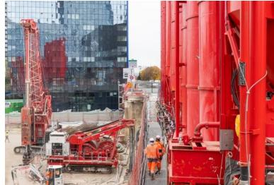
La boue bentonitique est traitée pour en éliminer les particules solides et les impuretés, puis elle est stockée jusqu'à ce qu'elle soit prête à être réutilisée. Ce processus en circuit fermé permet d'économiser de l'eau, de la bentonite et de réduire les coûts de traitement des déchets.
