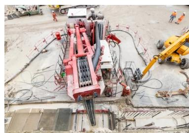
Excavation en cours dans la tranchée d'un panneau de la future paroi moulée. La boue bentonitique affuele. Celle-ci est injectée au fur et à mesure de la réalisation de l'excavation. Ces propriétés thixotropiques lui permettent de stabiliser les parois du trou de forage et d'empêcher le sol de s'effondrer.
