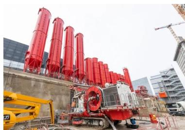
Le fait de l'exigüité de la parcelle, la totalité des installations nécessaires au traitement, au recyclage et au stockage de la bâche bentonite ont été implantées en surélévation de l'entreprise. C'est une paroi berlinoise qui assure la stabilité du dispositif.
