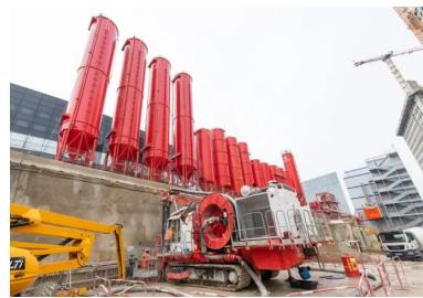
Le fait de l'exigüité de la parcelle, la totalité des installations nécessaires au traitement, au recyclage et au stockage de la boue bentonite ont été implantées en surélevation de l'entreprise. C'est une paroi berlinoise qui assure la stabilité du dispositif.
