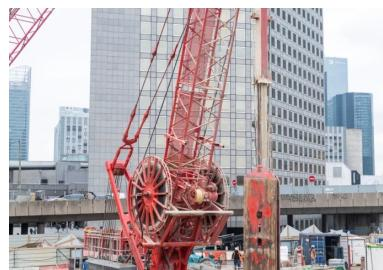
Vue d'une benne preuseuse hydraulique. Cette machine était utilisée pour l'extraction des sols meubles. Pour les sols plus durs, elle était remplacée par une hydrofrése, une hacheuse de paroi mise au point par Soletanche-Bachy.
