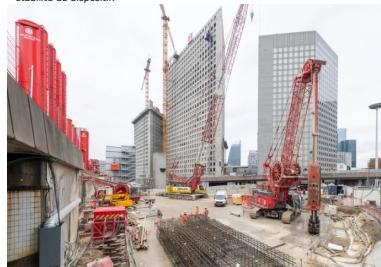
Le site présentait initialement un dénivelé important, peu propice à la mise en œuvre de travaux de fondations... D'importants travaux initiaux de terrassement ont permis de créer deux plateformes de travail horizontales, reliées par des rampes d'accès.
