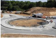
« Nous n'avons pas eu besoin d'utiliser du très gros matériel : la règle vibrante classique et l'aiguille vibrante se sont révélées une bonne méthode. Le savoir-faire de nos hommes a permis le reste. Le nivellement et la planéité ont été parfaitement assurés, l'écoulement des eaux s'effectuant sur les exutoires», ajoute Quentin *planeι*ιε Hognon.
