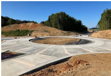
Vue du carrefour giratoire en béton en cours de finition. (© Joseph Abdo, JA-Consulting)
