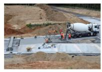
Contrôle de la consistan béton à l'aide de l'essai d'affaissement au cône d'Abrams. (©Quentin Ho
