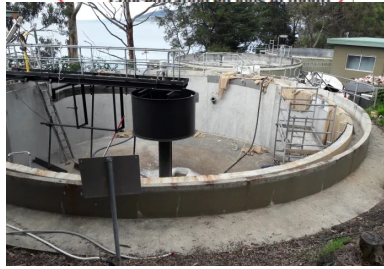
Bassin de décantation d'eaux usées réalisé en béton de ciments d'aluminates de calcium - Photo (c) Imerys
