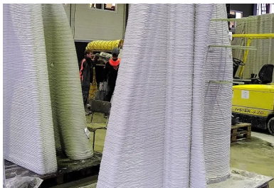
Des coques en béton imprimées 3D par dépôt de couches successives sont apposées sur la structure en béton armé pour servir de coffrage.
