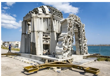
Au cœur du village de récifs artificiels, le module central mesure 6,50 m de haut sur une base de 48 m².
