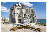
Au cœur du village de récifs artificiels, le module central mesure 6,50 m de haut sur une base de 48 m<sup>2</sup>.
