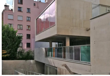
Vue sur la crèche à la sortie du passage sous porche.
