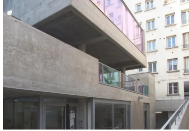
L'accès à la crèche se fait au niveau de la cour basse desservie par un ascenseur extérieur et par une rampe.
