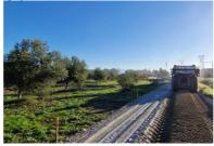
La malaxeur moderne Wirtgen WR 240 mélange le liant LVTS 13 avec le sol intimement sur une épaisseur foisonnée de 35 cm. (© B. Montagnini Ecostab)
