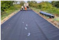
Mise en place d'un géotextile sur l'ensemble de la plate-forme. (© Jacob
