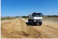
ÉPANDAGE DU LIANT HYDRAULIQUE ROUTIER LVTS 13 A L'AIDE D'UN EPANDEUR MODERNE STREUMASTER SW18 (COEFFICIENT LTV EST EGAL A 333). (© B. MONTAGNINI \_ECOSTAB)
