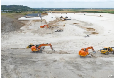
Vue générale du chantier de terrassement, conçu en circuit fermé déblais-remblais. (© Colas/ArtoisDrones)
