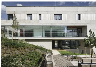
Façade ouest sur l'intérieur de l'îlot. La partie en béton brut abrite les appartements et la façade vitrée le cabinet médical.
