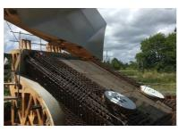
Des efforts colossaux transitent dans les massifs de pieds d'arcs, par l'intermédiaire des pièces d'ancrage des pilettes (les « disques » sur la photo), et des talliques en tête. cette raison que ègrent une très té d'armatures -) kg/m²
