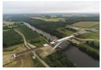
Le hourdis en béton armé di tablier du viaduc a été réalis à l'aide de deux équipages mobiles (structures blanche: sur la photo) par pianotage les plots, d'une longueur comprise entre 13 et 15 mètres, étaient coulés dans ur ordre permettant d'équilibrer l'ouvrage pendant son chargement tout en limitant les risques de fissuration de la urs De Vues
