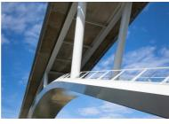
Soutenant le tablier mixte acier-béton par l'intermédiaire de pilettes disposées en « éventail », l'arc est constitué de deux segments rectilignes reliés au centre par un arc de cercle tangent. © Xavier BOYMOND
