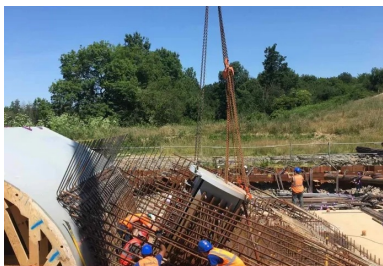
Amorce de pied d'arc en cours de réalisation. La précision de positionnement des différentes parties de l'ouvrage constituait l'un des défis techniques du chantier pour NGE GC. Ainsi, les inserts métalliques noyés du pied d'arc (platinas d'appareils d'appui et pièces d'ancrage) sont positionnés avec une précision de + ou - 3 millimètres. © photothèque NGE
