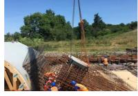
Amorce de pied d'arc en cours de réalisation. La précision de positionnement des différentes parties de l'ouvrage constituait l'un des défis techniques du chandier pour NGE GC. Ainsi, les inserts metalliques noyés du pied d'arc (platines d'appareils d'appareils d'appareils d'appareils d'apini de hou s'appareils d'apini de hou s'appareils d'apini de hou 3 millimètres. © photothèque NGE
