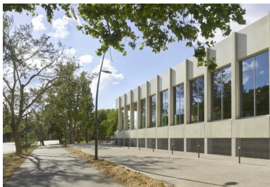
Vue de la façade sud de la halle des bassins. Elle est rythmée par des poteaux porteurs en béton, de 30 cm x 50 cm, espacés selon un pas de trame régulier de 2,55 m et surmontés par une poutre de couronnement, elle aussi en béton. L'ensemble exprime la grille constructive du projet, dessine son enveloppe et lui confère son identité.
