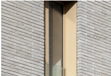
Les façades sont revêtues de briques en béton lisses ou texturées de couleur gris clair.
