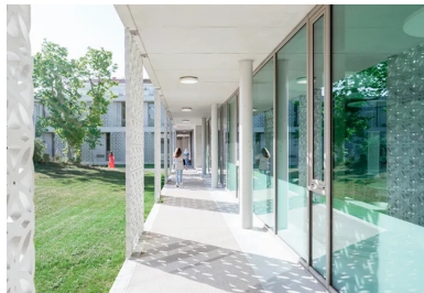
Les différents bâtiments de l'institution sont desservis par des courtoises extérieures. Celles-ci sont bordées et ponctuées par les mêmes éléments de panneaux de façade ajourés en béton fibré.
