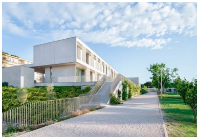
Avec la finesse d'une opération d'acupuncture, les constructions neuves ont été l'occasion de repenser la gestion des flux principaux de l'institution tout en positionnant la nature au cœur du projet.
