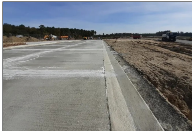
Les eaux de ruissellement sont recueillies dans des caniveaux en béton. (© Eric Sainquantin_DIRA)
