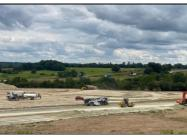
Vue de l'atelier de traitement du sol en place au liant LIGEX avec, au premier plan, un compacteur à bille lisse en ction. (© D
