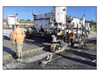
Mise en œuvre méca 'aide d'une machine offrages glissants. (©Eric ainquantin DIRA)
