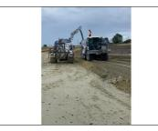
Un malaxage et les derniers ajustements en teneur en eau jusqu'à l'obtention de la teneur optimale se font en injection d'eau directement dans la cloche du pulvimixeur. (© D. Daguzan\_Ecostab)
