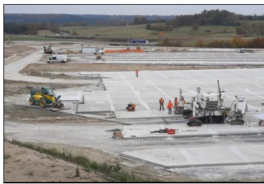
Quand elle progresse en clavage, la machine prend comme référence la hauteur des bandes existantes situées de part et d'autre. Le guidage en direction est donné par un fil. (© Luc Lefoll_Eurovia)
