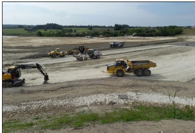
Vue générale de l'atelier de traitement de la couche de forme au LHR Ligex. (© Gilles Petit_DIRA)
