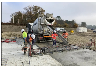
Mise en œuvre manuelle à l'aide d'une aiguille et d'une poutre vibrantes. (© Joseph Abdo_JA-Consulting)
