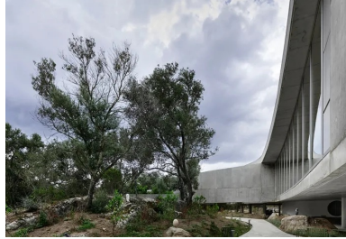
Le béton des façades et du sol semble couler dans le terrain et délimiter le jardin.
