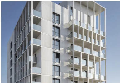
Les ondes verticales du béton matricé ajoutent rythme et vibrations aux façades des logements.
