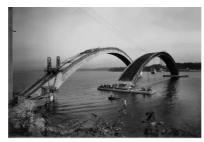
Une fois le premier arc achevé le cintre est déplacé sur des barges en béton jusqu'à l'emplacement du deuxième arc, où il était positionné en altitude en utilisant l'effet des marées. © Coll. Ville de
