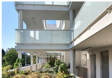
Les coursives sont mises à distance du volume bâti, pour éviter d'avoir des vues directes sur les logements. © Rue Royale
