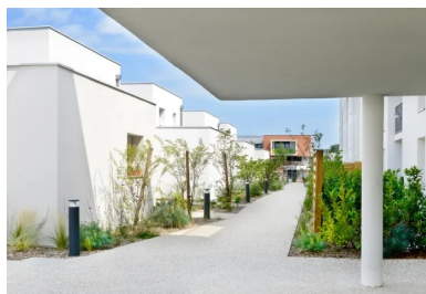
Sur le socle, l'espace commun entre l'immeuble collectif et les maisons en bande est aménagé comme un jardin suspendu. SPIRIT © Photo Aline Périer
