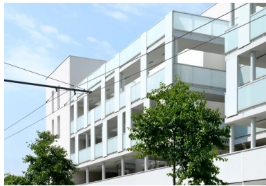
La desserte des appartements de l'immeuble collectif se fait par un système de coursives en balcon sur la rue d'Artik. SPIRIT © Photo Aline Périer
