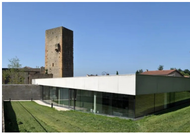
La prise de position du projet dans le site permet de conserver, depuis le parc de la mairie, la vision sans obstacle sur l'ensemble patrimonial et le cœur historique.
