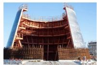
La partie conique du fût était coulée en deux levées successives de 11 m, grâce à des coffrages sur mesure.
