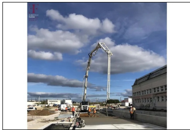
Bétonnage à la pompe et serrage du béton à l'aide d'un rouleau Striker.
