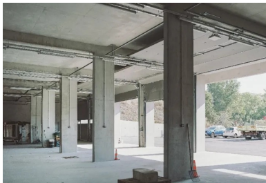
Vue sur le garage des véhicules d'intervention et des engins routiers ouvert sur la cour.
