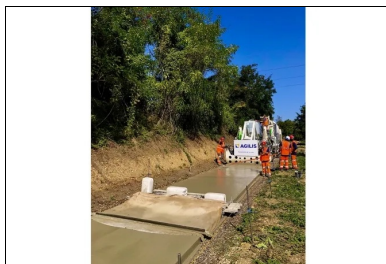
La machine à coffrages glissants, tractant la toile de jute, assure simultanément la réalisation du revêtement en béton et le traitement de surface.
