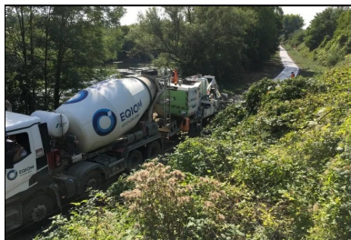
Le béton fabriqué à la centrale d'Illange d'EQIOM est livré par camions-toupies devant la machine à coffrages glissants.
