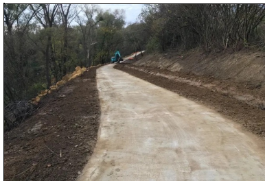
Travaux de mise à niveau des accotements associés aux travaux de stabilisation des berges.
