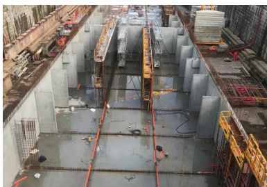
Vue du niveau inférieur du ponton en construction. Les voiles périphériques et le cloisonnement intérieur permettent de créer 12 alvéoles indépendantes garantissant le maintien en flottaison de l'ouvrage en cas d'avarie.
