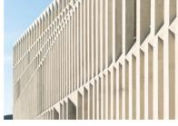
Détail de la façade sud en béton architectonique aver parement laissé brut de décoffrage
