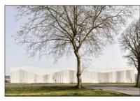
Les façades de la salle sont réalisées avec des panneaux préfabriqués en béton blanc de type mur à coffrage intégré (MCI), qui assurent de façon performante la protection acoustique de l'environnement extérieur.
