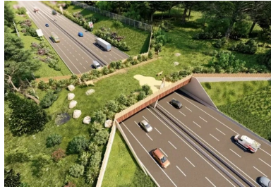
Pour optimiser ses fonctionnalités, un « éco-pont » est de préférence implanté sur une zone de déblais. © APRR - Agence Patte Blanche
