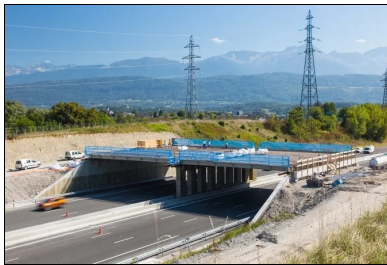
Passage à faune « Porte de Savoie » à Chignin, sur l'A43. Compte tenu de la largeur des ouvrages, le voile de la pile centrale est ajouré. © Régis Bouchu ACTOPHOTO
