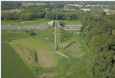
L'aménagement de l'ouvrage reproduit l'écosystème environnant pour compenser l'effet de rupture généré par l'infrastructure. © Romain Courtaud
