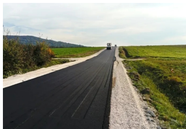
Compaction du BBCS. Mise à niveau des chemins d'accès aux parcelles agricoles.
