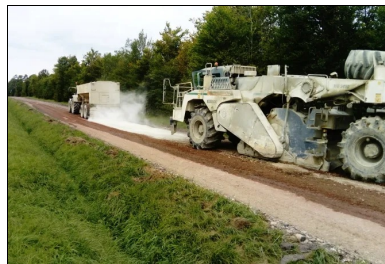
Chaussée rabotée et élargie à 6,60 m. Atelier de prétraitement en place à la chaux en action.
