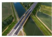
Vue aérienne du viaduc du canal de dérivation de la Saône rénové sur l'A36 (photo Sémaphore S. 60.). L'ouvrage est constitué d'un double tablier mixte de 100 m de long à poutres extradossées de type Warren. Le chantier de réfection de l'étanchéité était soumis à deux contraintes d'exploitation : l'impossibilité de couper la circulation des véhicules sur l'autoroute et des péniches sur le canal.
