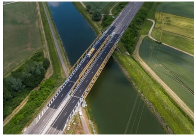
Vue aérienne du viaduc du canal de dérivation de la Saône rénové sur l'A36 (photo Sémaphore & Co). L'ouvrage est constitué d'un double tablier mixte de 100 m de long à poutres extradossées de type Warren. Le chantier de réfection de l'étanchéité était soumis à deux contraintes d'exploitation : l'impossibilité de couper la circulation des véhicules sur l'autoroute et des péniches sur le canal.
