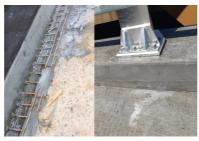
Joint de reprise des longrines (photos APRR). Les armatures (photos APRR). Les armatures (photo de gauche), placées au fond d'une saignée, permettent de connecter le BFUP de la longrine à celui du hourdis. Ce dispositif de couture permet de garantir, par l'intermédiaire d'un recouvrement des BFUP, la parfaite continuité de "Viranchaifs (hont) que forite).
