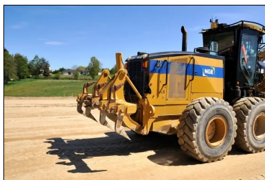
Avant épandage du LHR, le matériau est scarifié.
