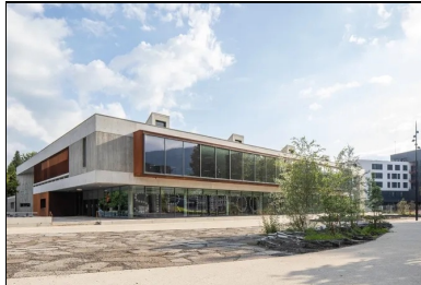
En façade nord, le grand bow-window éclaire la salle de self-service.
