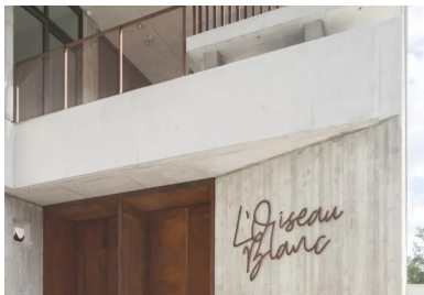
Vue de l'entrée du restaurant « L'Oiseau Blanc ».
