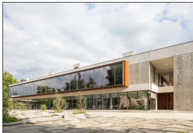
Vue sur la façade nord, la transparence du rez-de-chaussée met en vitrine « La Rue Gourmande » sur l'allée Diderot. À l'angle nord-ouest, le creux dans le volume ainsi que le jeu des parois pleines et des vides signalent une des entrées de « La Rue Gourmande » et celle du restaurant « L'Oiseau Blanc ».
