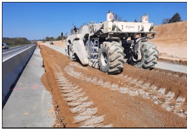
Malaxage à l'aide d'un pulvimixeur.
