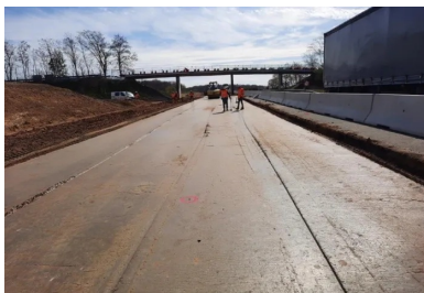
Contrôle du compactage au gamma-densimètre.
