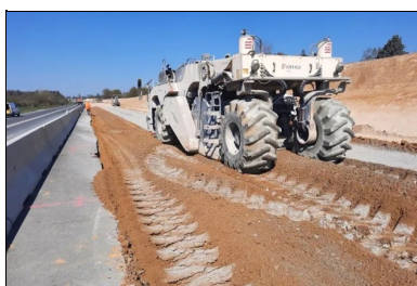
Malaxage à l'aide d'un pulvimixeur.
