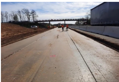
Contrôle du compactage au gamma-densimètre.
