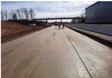
Contrôle du compactage au gamma-densimètre.
