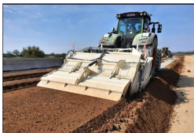
Le matériau et le liant sont malaxés à l'aide d'un malaxeur tracté.
