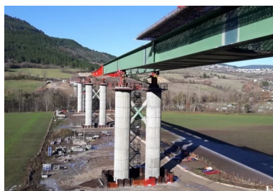
Lancement de la charpente. D'abord assemblée sur une plateforme installée sur l'une des deux culées de l'ouvrage, le tablier a été mis en place au cours de huit lancements successifs, muni d'une partie du ferrailage du hourdis supérieur ainsi que des prédalles et du ferrailage du hourdis inférieur. © CEREMA
