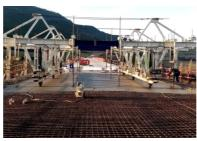
Bétonnage d'un plot du hourdis supérieur à l'aide d'un équipage mobile. Le bétonnage est réalisé par « pianotage », afin de répartir les charges de manière homogène. ©DIR Med
