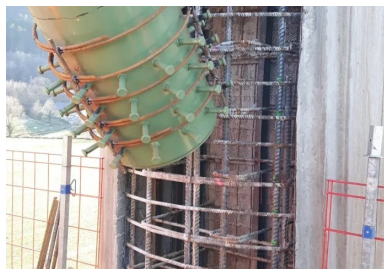
Clavage des entretoises des piles avec les fûts. Des réservations sont réalisées dans les fûts au droit de la jonction avec les extrémités des croix métalliques. Un ferrailage (non visible sur la photo) reliant les deux éléments est mis en place avant de couler le béton qui formera les bossages (visibles sur la photo n° 6). © CEREMA
