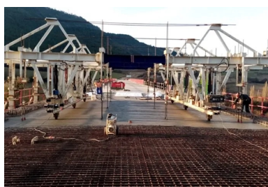
Bétonnage d'un plot du hourdis supérieur à l'aide d'un équipement mobile. Le bétonnage est réalisé par « pianotage », afin de répartir les charges de manière homogène. © DIR Med
