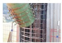
Clavage des entretoises des piles avec les füts. Des réservations sont réalisées dans les füts au droit de la jonction avec les extrémités des croix métalliques. Un ferraillage (non visible sur la photo) reliant les deux éléments est mis en place avant de couler le béton qui formera les bossages (visibles sur la photo n°6). ©CEREMA
