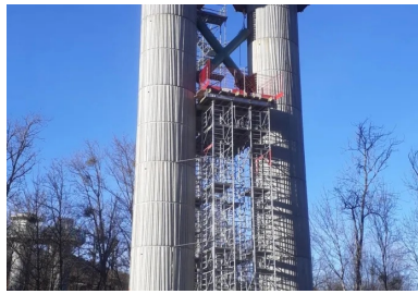
Une double pile en cours de construction. Les fûts des piles, coulés en place dans des coffrages elliptiques, sont ornés d'un motif en béton matricié. © CEREMA
