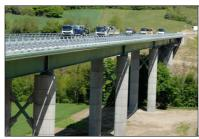
Epreuves de chargement du viaduc. Cette étape classique et obligatoire de la cross-construction de la cross-construction
