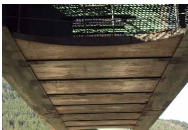
Prédalles participantes du hordis inférieur - phase de lancement de la charpente. Mises en place avant le lancement, elles serviront de fond de coffrage lors du coulage du hordis inférieur. ©CEREMA
