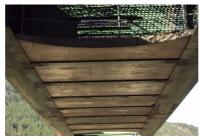
Prédalles participantes du hourdis inférieur – phase de lançage de la charpente. Mises en place avant le lançage, elles serviront de fond de coffrage lors du coulage du
