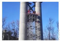
Une double pile en cours de construction. Les fûts des piles, coulés en place dans des coffrages elliptiques, sont ornés d'un motif en béton matricé. ©CEREMA
