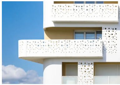
Des panneaux préfabriqués en béton perforés de trous de différents diamètres viennent au niveau des balcons et des loggias. Ils jouent un rôle de filtre et préservent l'intimité des logements.
