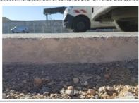
Pour la reprise de bétonnage, le joint de construction est scié proprement sur toute l'épaisseur de la couche de BCR puis humidifié. On voit bien la qualité de compactage
