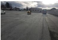
Compactage du BCR à l'aide de deux compacteurs vibrant VT2 et PV2. (© Colas)
