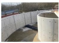
Les voiles des bassins ont été réalisés à l'aide d'un outil coffrant circulaire fabriqué sui mesure. Les rayons de courbure de chacun des bassins étant différents, le coffrage était réglé pour épouser précisément les courbes.
