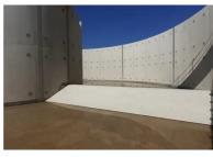
Les bétons des bassins de la station d'épuration sont formulés pour pouvoir résiste aux attaques chimiques des effluents en cours de
