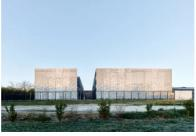
L'enveloppe de l'ouvrage est réalisée avec des panneaux préfabriqués blancs en béton fibré à ultra haute
