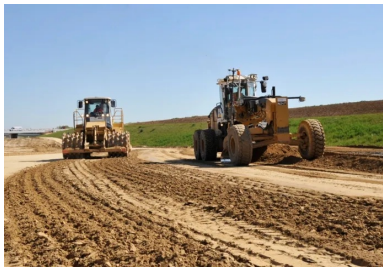
Compactage au Tamping SP2.
