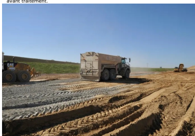
Après scarification, épandage du liant hydraulique routier.
