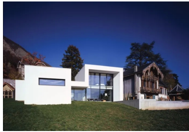
L'expression volumétrique du projet s'attache à réinterpréter les typologies des maisons anciennes constituant le quartier, avec un corps majeur vertical sur deux niveaux et un développement latéral de moindre hauteur. Ainsi, un dialogue s'établit avec la maison située juste à côté.
