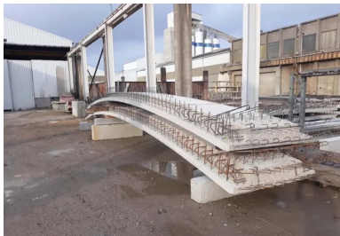
Pour réaliser les 638 pétates qui couvrent les 11 digesteurs, la préfabrication a été privilégiée.
