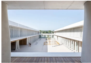
Les circulations du lycée sont couvertes mais ouvertes, les cadrages offerts par ces espaces sur le grand paysage participent à l'ambiance apaisée du lycée.
