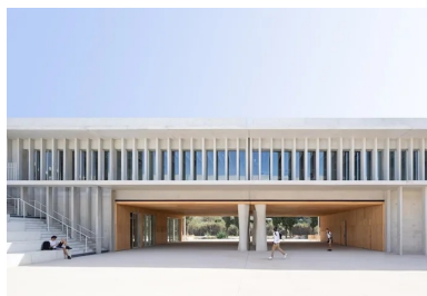
Les espaces de préau sont marqués par un travail de tasseautage bois qui assure la gestion du son confort acoustique et confère un aspect chaleureux à l'ensemble.
