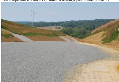
Un enduit monocouche prégravillonné a été appliqué pour protéger la couche de forme et assurer une bonne prise hydraulique du mélange
