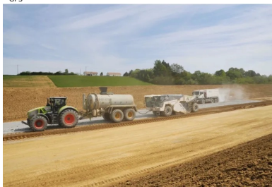
Épandage du LHR Rolac Premier à la surface du matériau (à l'aide d'un épandeur asservi avec contrôle pondéral) et malaxage du matériau du LHR par un malaxeur Wirtgen WR 240i avec injection d'eau dans la cloche
