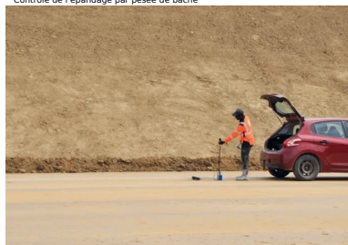
Contrôle du compactage à l'aide d'un gammadensimètre
