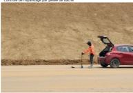
Contrôle du compactage à l'aide d'un gammadensimètre
