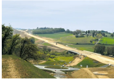
Vue d'ensemble d'un tronçon du chantier du contournement de Gimont. Il permettra de relier Toulouse à Auch, tout en évitant la ville.
