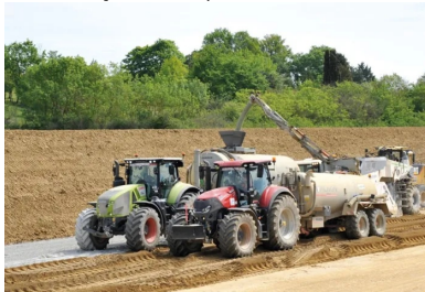
Apport d'eau par un tracteur directement dans la citerne pour éviter l'arrêt des engins
