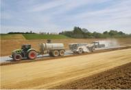
Épandage du LHR Rolac Premier à la surface du matériau (à l'aide d'un épandeur asservi avec contrôle pondéral) et malaxage du matériau du LHR par un malaxeur Wirtgen WR 240i avec injection d'eau dans la cloche
