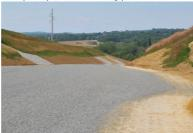
Un enduit monocouche prégravillonné a été appliqué pour protéger la couche forme et assurer une bonne prise hydraulique du mélange
