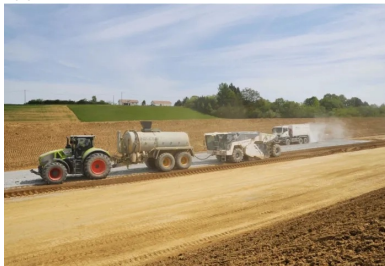
Epandage du LHR Rolac Premier à la surface du matériau (à l'aide d'un épandeur asservi avec contrôle pondéral) et malaxage du matériau du LHR par un malaxeur Wirtgen WR 240i avec injection d'eau dans la cloche
