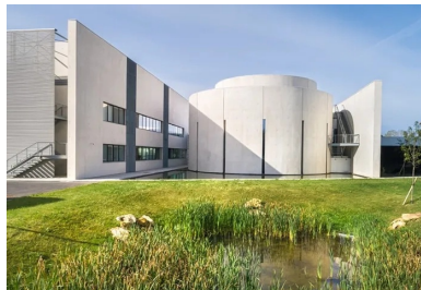
Les voiles courbes du hall et de l'auditorium, ainsi que les façades des laboratoires sont en béton autoplaçant blanc.
