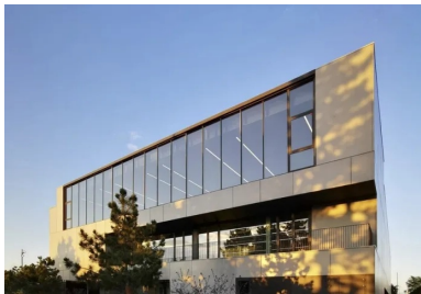
Façade ouest avec la salle de tir à l'arc/tennis de table au dernier étage.
