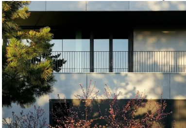
Le dessin des lignes horizontales et verticales des joints entre panneaux préfabriqués ainsi que de grandes ouvertures vitrées rythment les différentes façades.
