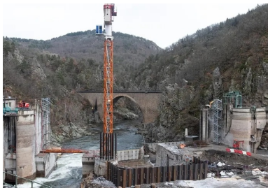
Vue prise de l'amont après la réalisation des batardeaux.
