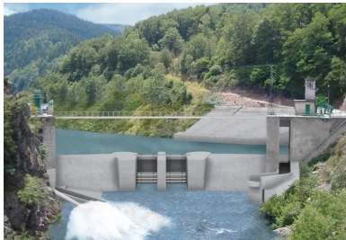
Photo-montage de l'ouvrage terminé. D'une hauteur de 7 m, le nouveau barrage est équipé de vannes amovibles qui seront ouvertes trois mois par an.
