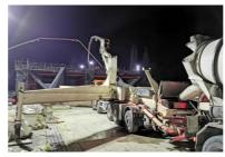
Le coulage de nuit de la traverse supérieure du pontrail a nécessité l'utilisation simultanée de deux camions pompes, de deux centrales à béton d'Eqiom, et mobilisé près de 50 personnes.
