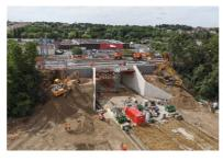
Une fois le pont-rail dans sa position définitive, la plateforme ferroviaire, déjà préchargée sur l'ouvrage (ballast et panneaux de voies), a été raccordée aux plateformes en attente de part et d'autre de la brèche. Parallélement, les derniers remblaiements latéraux ont
