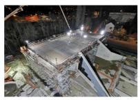
L'un des moments forts du chantier s'est tenu, par chance, dans la nuit du 13 au 14 mars 2020, soit deux jours avant le premier confinement! Il s'agit du coulage de la traverse supérieure du pont, lors duquel 700 m3 de béton ont été couldes en continu par pompage, entre 20 h et 8 h du matin.
