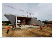
le remblai ferroviaire, le parcours de ripage a été scalpé à la bonne cote, afin de permettre à l'ouvrage de glisser sans effort excessif. Le ripage proprement dit a alors pu se dérouler : huit heures ont été nécessaires pour faire parcourir au pont-rail de quelque 6 500 tonnes les 49 mètres oui le séparaient de mètres oui le séparaient de
