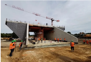
Une fois la brèche créée dans le remblai ferroviaire, le parcours de ripage a été scalpé à la bonne cote, afin de permettre à l'ouvrage de glisser sans effort excessif. Le ripage proprement dit a alors pu se dérouler : huit heures ont été nécessaires pour faire parcourir au pont-rail de quelque 6 500 tonnes les 49 mètres qui le séparaient de son emplacement définitif.
