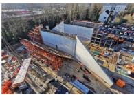
Le pont-rail a été construit à 49 mètres de son futur emplacement, au milieu du parking d'Épinay-sur-Orge. L'Ouvrage en beton armé est constitute d'un cadre rectangulaire (au centre de la photo), complété de deux travées d'approche reposant sur des bracons inclinés à 45°. Quatre murs en ailes (f'un d'eux est visible en habe à d'oriole) viennent compléter motifel viennent compléter motifel viennent compléter.
